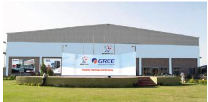
▲巴基斯坦格力空调生产基地厂房
